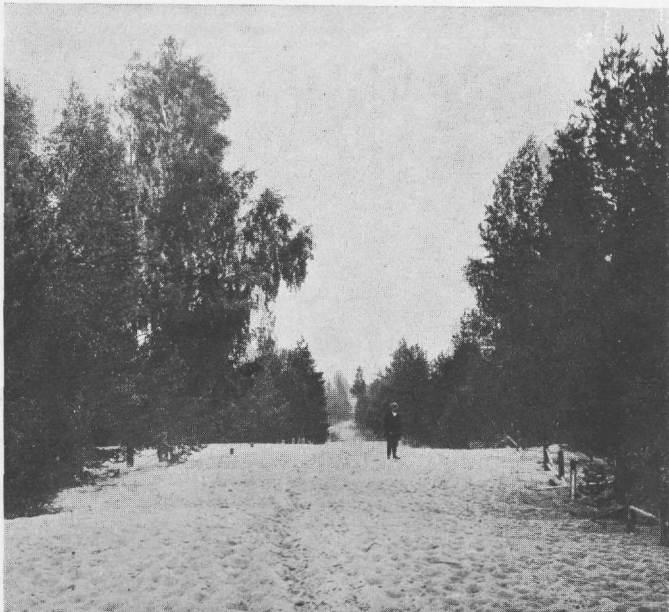
Kuva 8. Lentohiekan valtaama maantie, Muurilan kylästä 3 km. luoteeseen.
