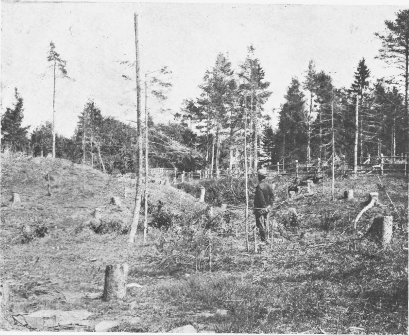
Kuva 1. Huvilapalsta, jolta rakennus on siirretty pois ja metsä hävitetty. — Kuokkala.
