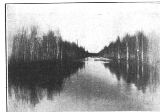
(15). Maantie Kolarin Teuravuomalla 9. V. 1934 tulvan jälkeen. Vedet ovat tulvineet oikeanpuoliselta ojittamattomalta suoalueelta yli maantien metsäojitetulle suoalueelle vasemmalla. Valok. A. Miittinen.
