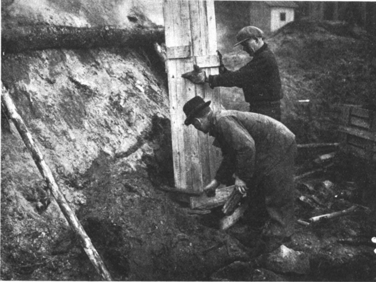
Kuva 13. Miilu on lämminnyt, kiuas on purettu ja torvea pystytetään paikoilleen.
