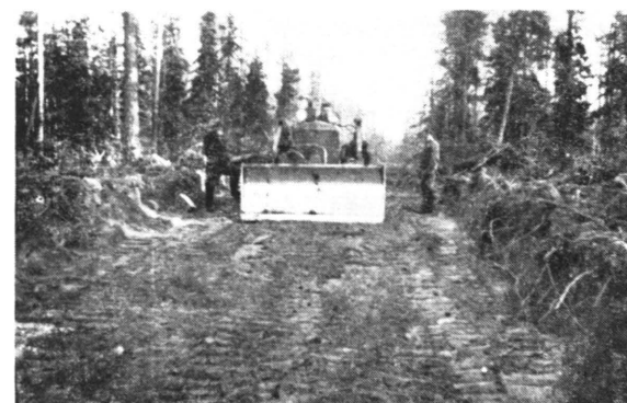
Huoltotien tekoa Kolarin hoitoalueen Naalastenjoen seudulla. Kahdessa viikossa aukeni 8 tonnin Oliwer-traktorilla 8 km:n pituinen tie Karjalaiseen. Valok. 1949 A. Miettinen.
