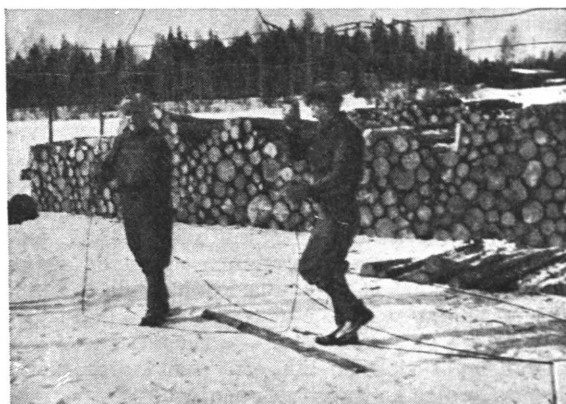
Nippupinoja käytettäessä nippulangat laitetaan paikoilleen ennen pinojen tekemistä (Metsäteho).
