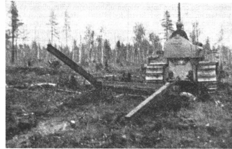
Kuva 1. Caterpillar D 4 telaketjutraktori. Vetokoukulla voima 43 hv. Traktorin perässä näkyvissä laikuttaja m/Korpivaara.
