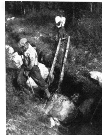
Kuva 3. Kivikelkka M 1 työssä. Kelausvaihe alkamassa. Kuva ei ole kokeilutyömaalta. Valok. Paavo Yli-Vakkuri.
