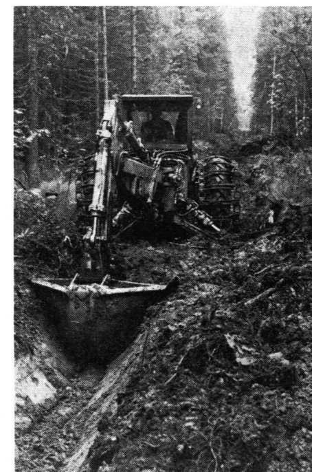
Kuva 2. Kaivuri ruoho- ja heinäkorven koeojaa kaivamassa.
