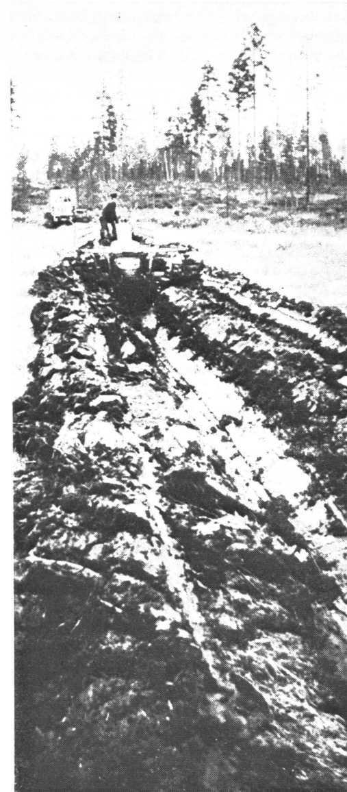
Kuva 8. Metsäoijituksen koneellistaminen 1950-luvulla muutti koko oijituksen tekniikan. Kuvassa oja-aura työssään 1950-luvulla. Valok. O. Huikari.
