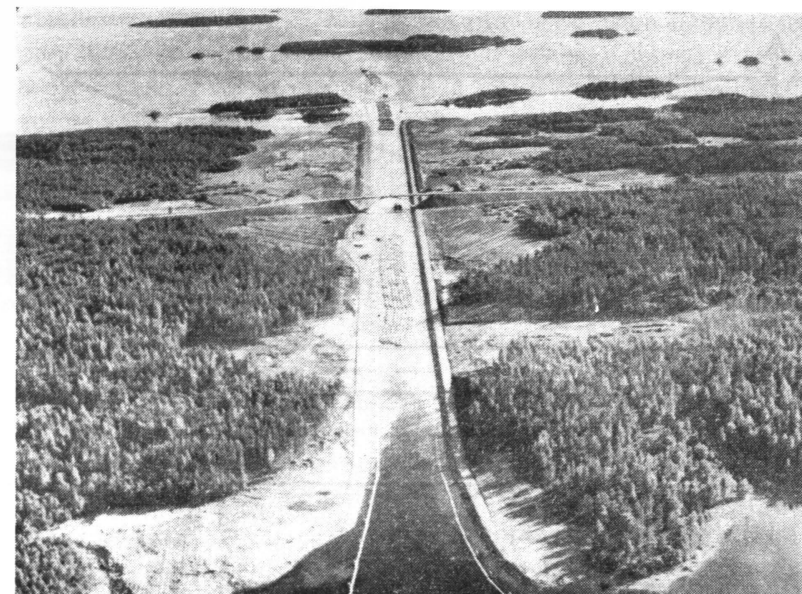
Kuva 5. Ison-Saimaan kanavat ovat avokanavia eivätkä ne keskeytä yhtäjaksoista hinausta ja vaadi siten uittoyhdistystä. Kuvassa v. 1960 valmistunut Haponlahden avokanava. Valok. A. J. Kuosmanen.
