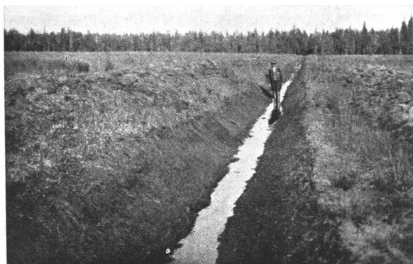
Kuva 9. Oja helluvalla rimpimäisellä suolla Soanlahden Pikku-Kitsunrim- millä, kaivettu 1924—25. Alkuaan 1.50 m syvä oja on painunut parissa vuo- dessa 0.80 m. Kaivettaessa oli oja pönkitettävä rimoilla ja seipäillä. Helluvan pinnallisen valkosammal-niittyvillaturpeen kuivumisen ja kutistumisen jäl- keen on oja alkanut kestää hyvin saraturpeessa. Ojan sivukaltevuus, alkuaan 1/0.8—11.0 ja pohjaleveys, 0.40—0.50 m, eivät ole pienentyneet.
