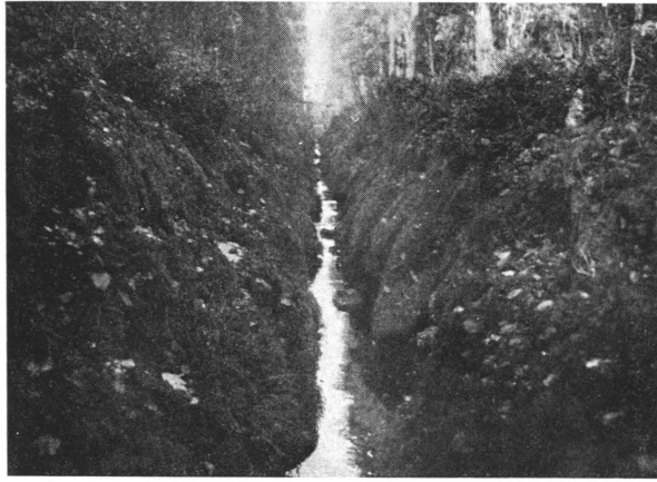
Kuva 12. Niska- ja laskuoja (Lg) Virtain hoitoalueen Kahilan valtionmaalla, kaivettu 1915. Sivukaltevuus alkuaan 1/0.6 ja ojan pohja 0.30 m. Oja syventynyt, pohja laajentunut ja sivukaltevuus pienentynyt. Ojan seinämät sammaloituneet ( Polytr. comm. , Sph. acutif. , Sph. rubell. ja Hyloc. pariet. Vesirajassa Sph. ripar. ). Valok. 1930 s. E. M:KI.
