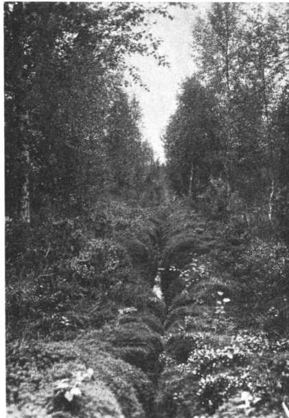
Kuva 13. Korpinoikelman oja, kaivettu 1919. Ojan laiteille laskeutuneen hiekan ja mudan päälle on kasvanut nopeasti tuuhea karhunsammalpeite, joka on tukkinut päältä ojan. Karhunsammalen alla avonainen, syvä »salaoja». Valok. 1930 s. E. M:KI.
