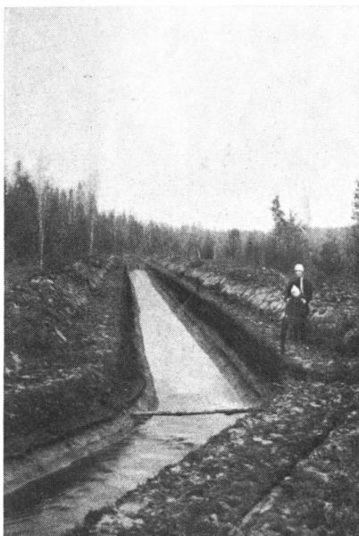
Kuva 8. Laskuoja savipohjaisella suolla, kaivettu kesällä 1929, valokuvattu samana syksynä. Ojan pohja alkanut syöpyä ja pyöristyä muutaman kuu- kauden aikana. Kymmene Ab. Sippolan tila. Valok. 1929 G. DUNCKER.
