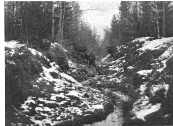
Kuva 15. Laskuoja (E-F) Jaakkoinsoon kokeilualueessa. Alkuaan pieni oja hiekkamaassa laajentunut n. 6 m leveäksi putouksen taitekohdassa. Oja kaivettu 1909. Valok. 1925 s. E. M:KI.
